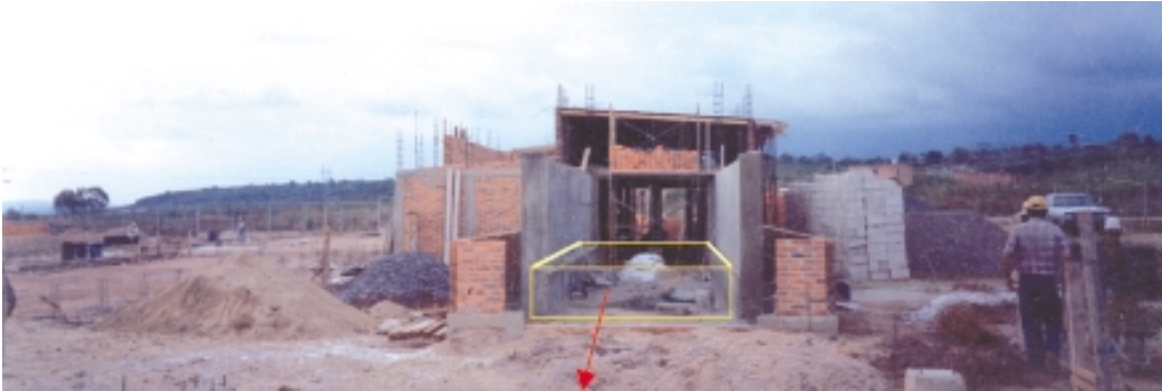
Pleno sobre el piso
