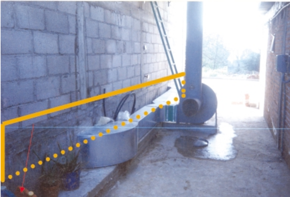
Pleno sobre el piso sin excavación
